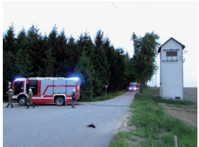
Das RLF Stillfüssing konnte den Brand in der Trafostation Watzenbach rasch löschen
